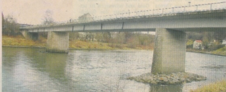
Die Gesamtkosten der Generalsanierung der Brücke zwischen Ach und Burghausen sind eine Million Euro. Davon trägt Bayern 350.000 € und 650.000 € das Land OÖ. Foto: Land OÖ
